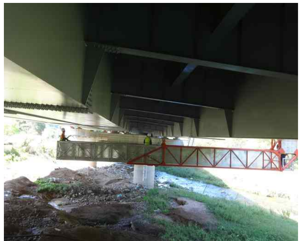
교량점검차를 이용한 근접조사
