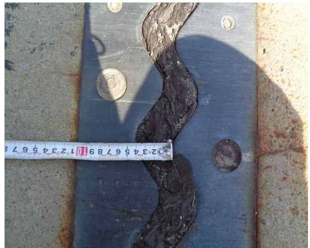
신축이음 유간 측정
